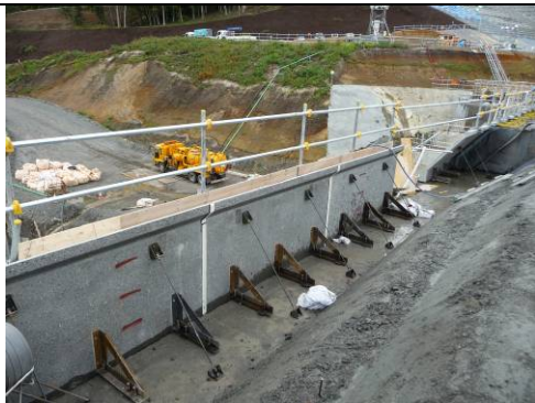
写真3 下流面保護コンクリート
