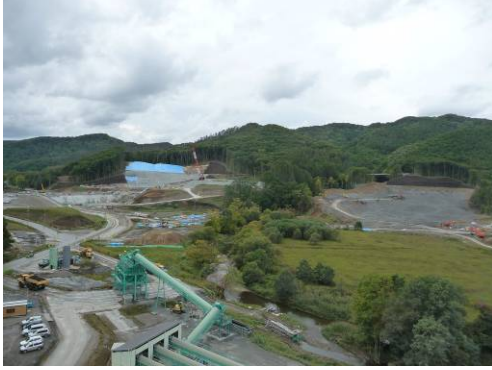
写真1 堤体（左）及び母材山（右）
