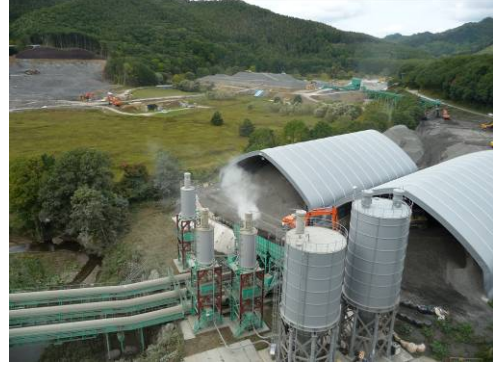
写真2 CSG 保管場所、混合設備
