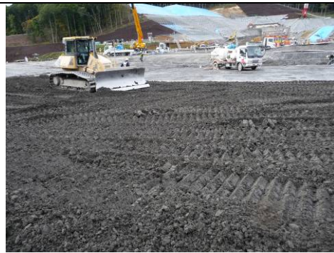
写真3 CSG 打設、敷均しの様子
