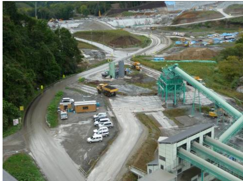
写真3 CSG 積込設備と運搬の様子
