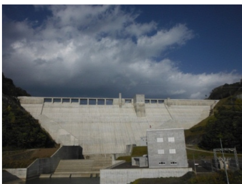
写真-1 夕張シューパロダム全景
