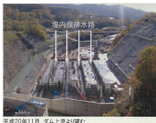
写真-2 堤内仮排水路（配布資料より）
