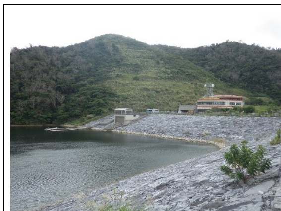
写真-1 羽地ダム（上流側）
