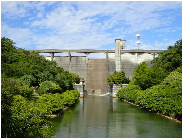
写真-3 漢那ダム (本ダム全景)
