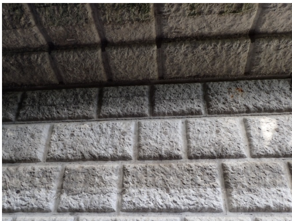
写真-4 漢那ダム (本ダム堤体石積み模様)
