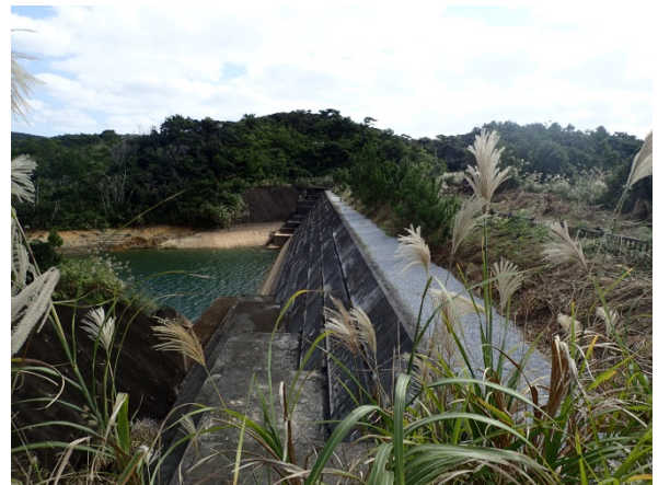
写真-2 沢部止水処理（台形CSG構造物）
