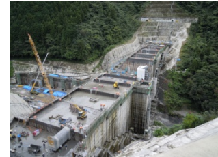
写真-1 ダム本体工事全景
