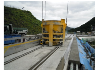
写真-3 コンクリート軽量バケット
