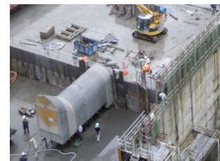
写真-5 監査廊 (PC化)
