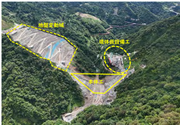
下流より上流を望む
