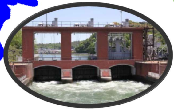
宇治発電所石山制水門
