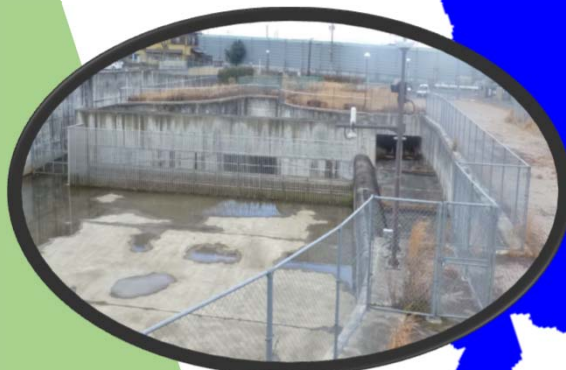
大津放水路三田川分水施設
