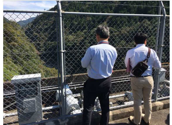
【岩屋戸ダムの天端見学②】
