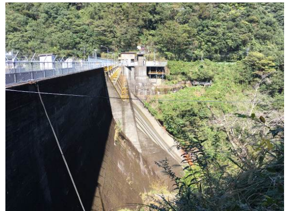
【岩屋戸ダムの下流面】
