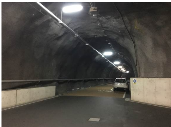
【小丸川発電所地下通路】
