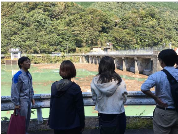
【岩屋戸ダムの上流面見学】
