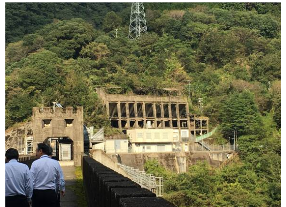
【塚原ダムコンクリートプラント跡】
