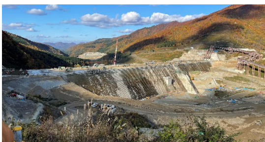
堤体工事の展望台にて
