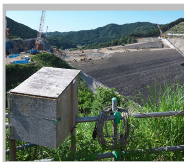
南摩ダムのタイムラプス
