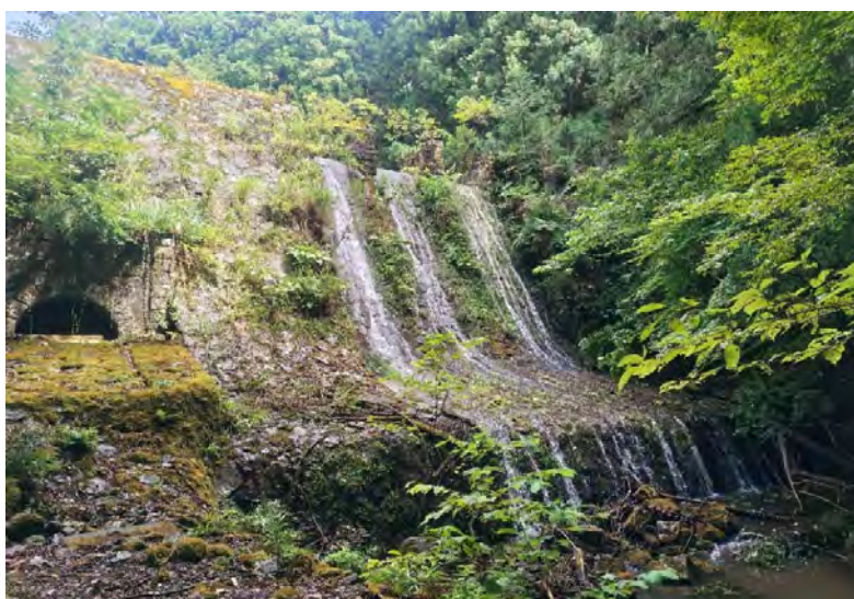
⑪桂堰堤を下流から望む（放流中）
