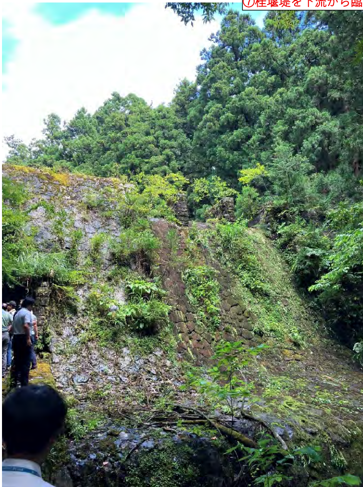
⑦桂堰堤を下流から臨む
