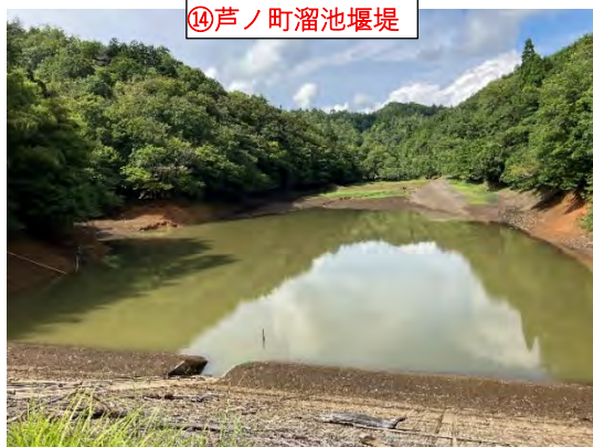
⑭芦ノ町溜池堰堤
